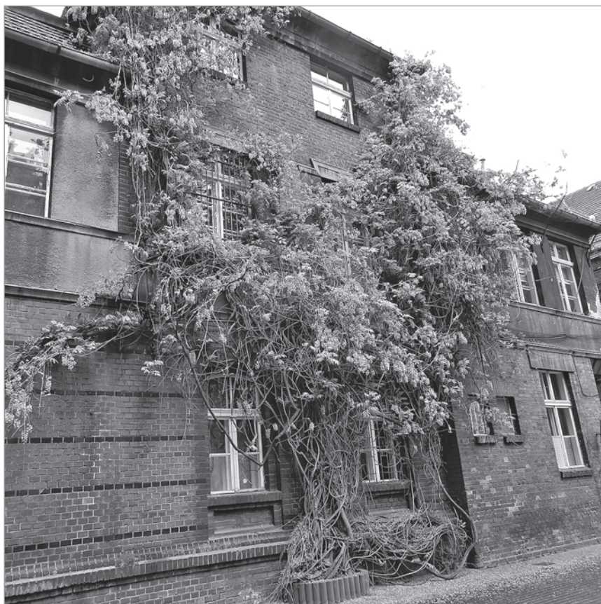
Jeden z budynków Szpitala Specjalistycznego nr 2 przy ul. Stefana Batorego w Bytomiu. Fot. Danuta Sokal.
